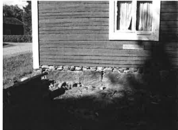
Lähes valmis seinä, hirret on jo korjattu, maalaus on vielä kesken.
